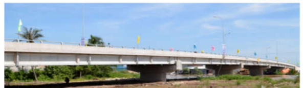
Công trình 10 CẦU TRÊN ĐƯỜNG TỈNH 883 Tỉnh Bến Tre
