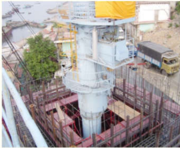
Thi công móng cọc bằng công nghệ giếng chìm, hai ép
