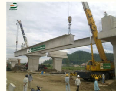
Thi công đúc & lắp các loại dầm L, chiều dài L = 33m , dầm super T, chiều dài L = 40m
