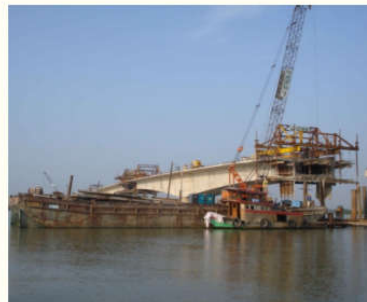
Công nghệ thi công dầm hộp bằng phương pháp đúc hẫng cân bằng
