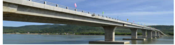
Công trình cầu BẾN THỦY II Tỉnh Nghệ An - Hà Tĩnh
