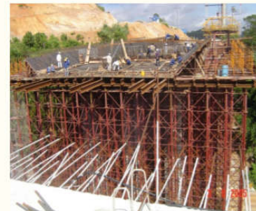
Công nghệ thi công dầm hộp bằng phương pháp đúc trên đà giáo
