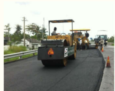
Thi công thảm đường bằng bê tông nhựa
