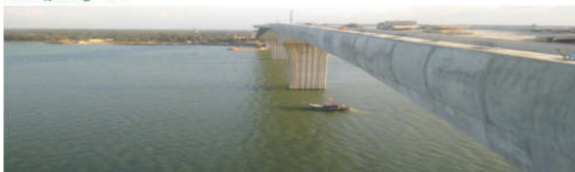
Công trình cầu CỬA ĐẠI Tỉnh Quảng Nam
