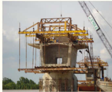
Thi công đúc khối K0 trên đà giáo dạng chống
