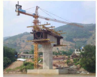
Thi công đúc khối K0 trên đà giáo dạng công son
