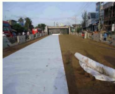
Thi công tường chắn đất có cốt
