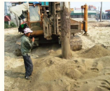
Công nghệ xử lý nền đất yếu bằng cọc cát
