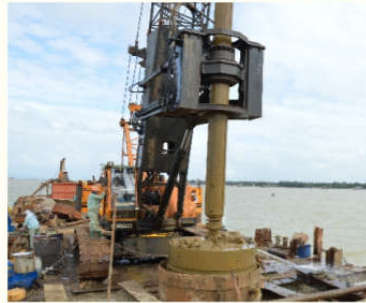
Thi công móng cọc khoan nhồi đường kính lớn D = 2,0m
