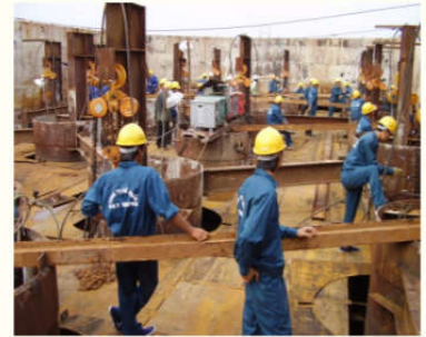
Thi công hố móng bằng khung vác cọc ván thép kích thước lớn 36m \times 36m
