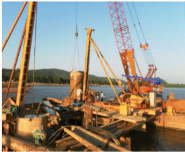
Thi công móng cọc khoan nhồi qua hàng caster
