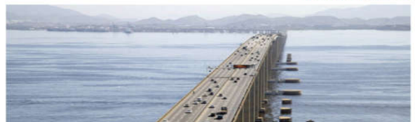
Công trình cầu TÂN VŨ - LẠCH HUYỀN Thành phố Hải Phòng
