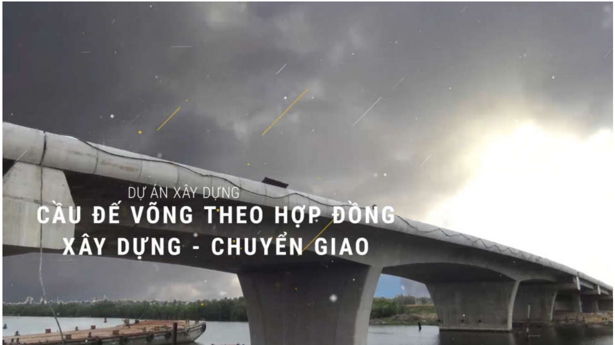
Hình 9: Dự án xây dựng cầu Đế Vĩng
